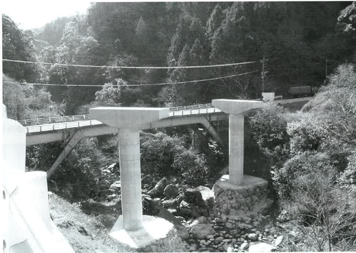
平似田太ノ浦線改良工事9工区（龍頭泉上）
