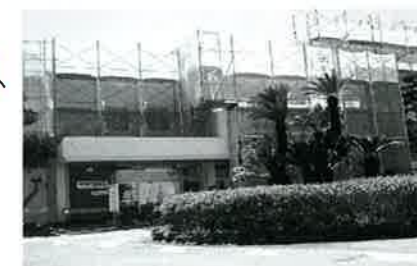
改修中の教育センター分室
