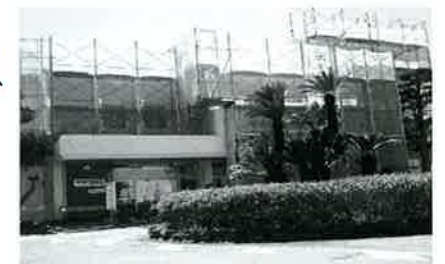
改修中の教育センター分室
