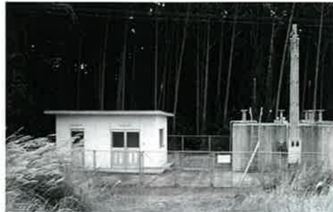
中岳地区浄水場
