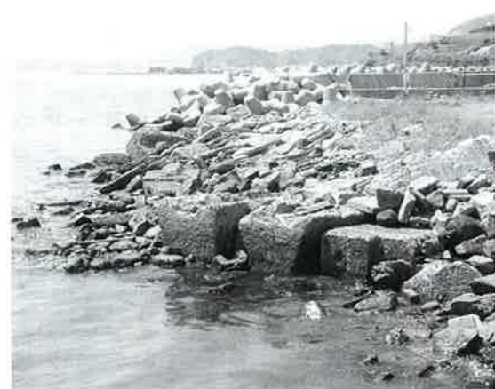
町長選挙出馬の折、環境整備を言及した千綿漁港外港（ごみやコンクリート片が散乱し、環境被害と災害被害が懸念される）
