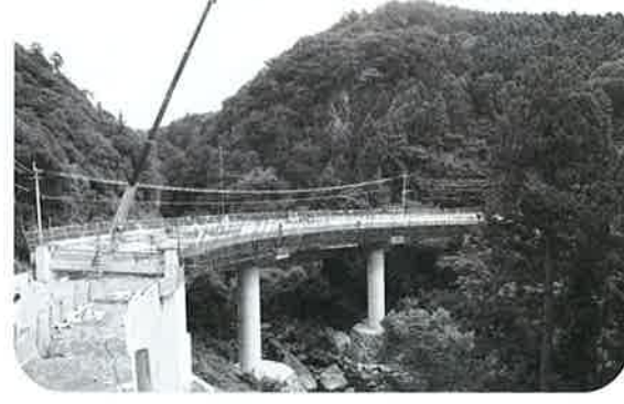
▲防衛施設周辺整備（平似田太ノ浦線道路改良工事） ～ H24.2 月末完成予定 ※写真は龍頭泉橋付近
